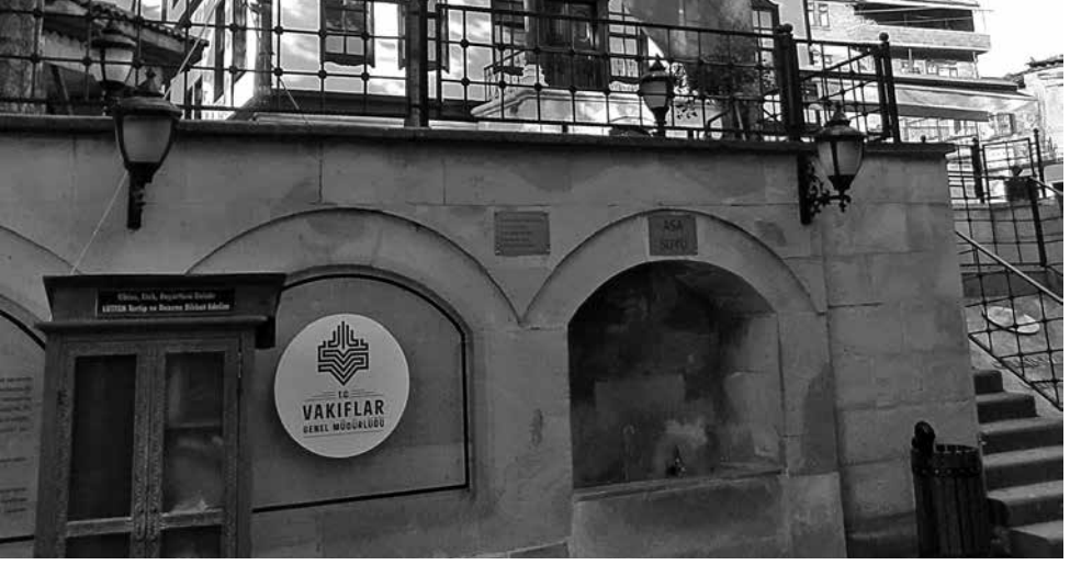
Resim 14. Asa suyu, türbeden konakların bulunduğu avluya çıkan merdiven, Bayraklı Köşk, şadırvan, müze binası
