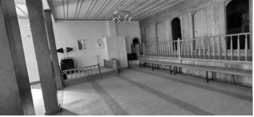
Resim 10. Caminin zemin katında kuzey kısmında mahfili taşıyan ahşap direkler, zemin kat müezzin mahfili, halvethaneler, halvethane önündeki koridor, ahşap korkuluklar.
