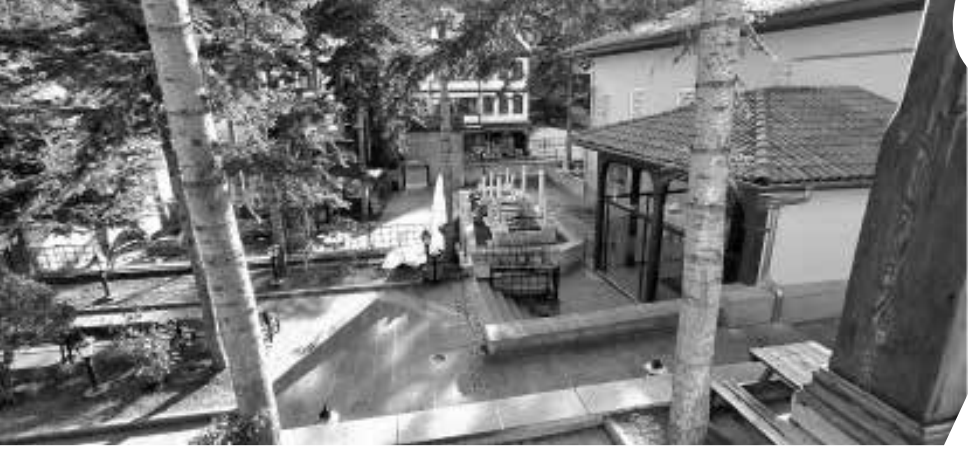
Resim 4. Cami sundurması, hazire, taçkapı. Külliye'nin girişi ile konaklar arasındaki kot farkını gösteren merdivenler.
