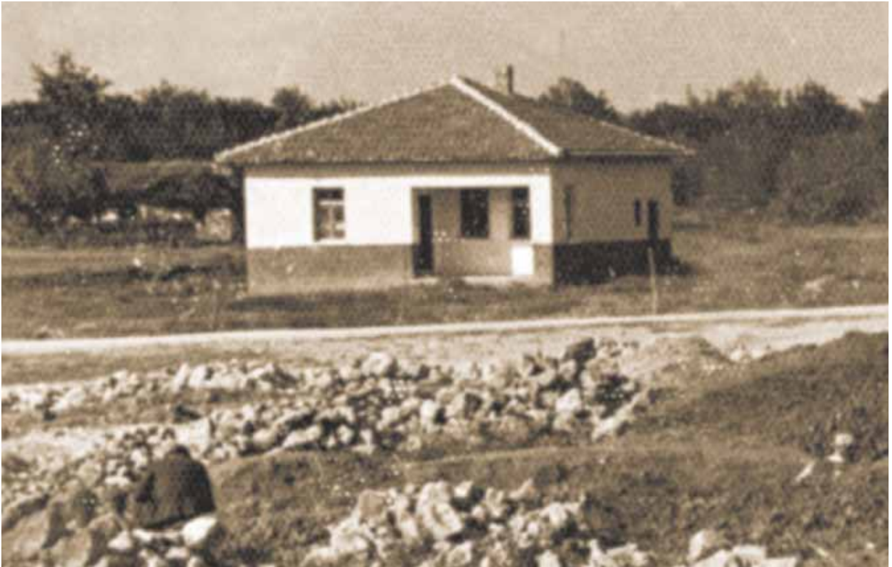
Bağcılar Meydan'daki evin hemen arkası meyve ağaçları ile doluydu. (Bağcılar Belediyesi Arşivi)
