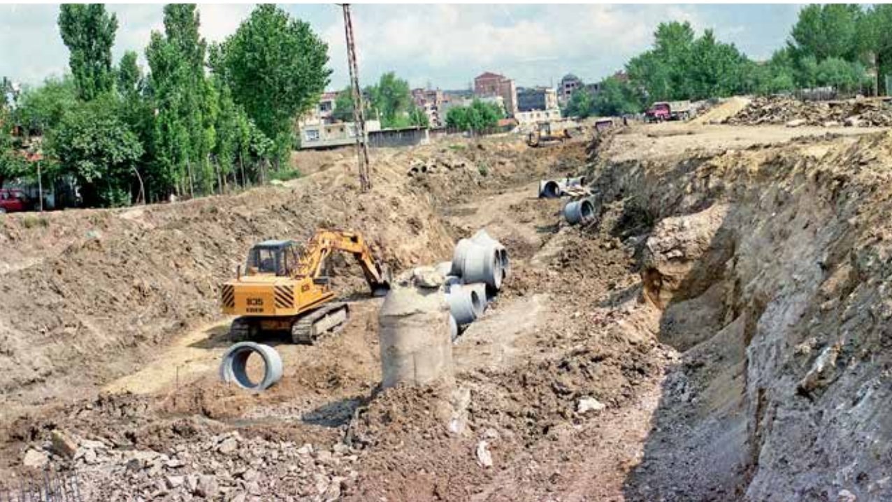
1992’den sonra kanalizasyon çalışması (Bağcılar Belediyesi Arşivi)
