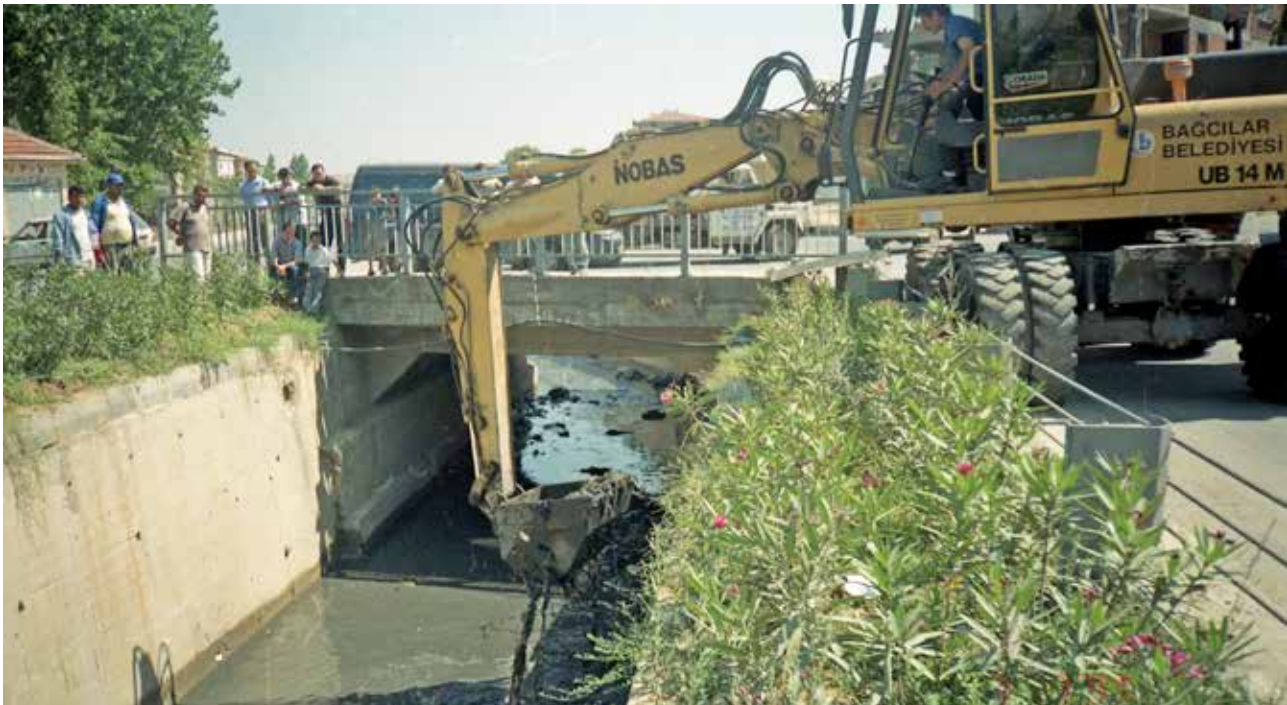
Islah edilen derelerin kaba atıklardan temizlenme çalışması (Bağcılar Belediyesi Arşivi)
