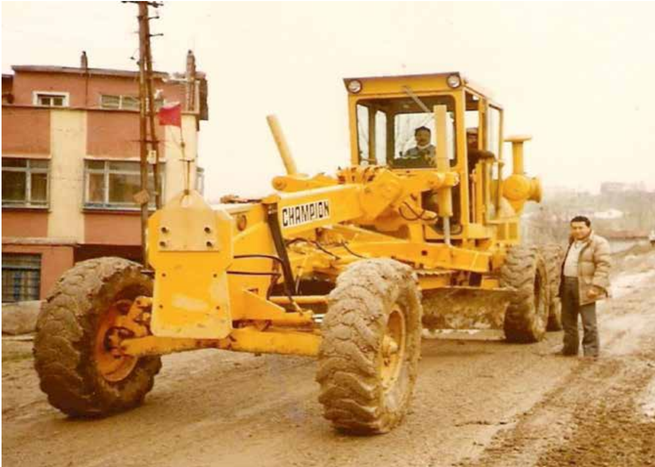
Güneşli Kazak Mahallesi'nde yol düzenleme çalışması
